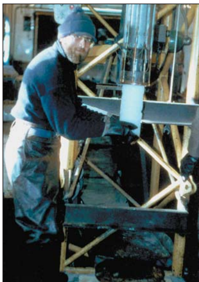
Забуривание скважины 5Г.
