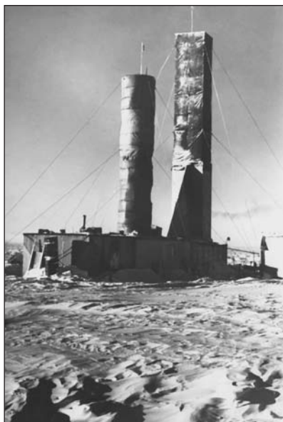
Буровой комплекс над скважинами 1 и 3Г.
